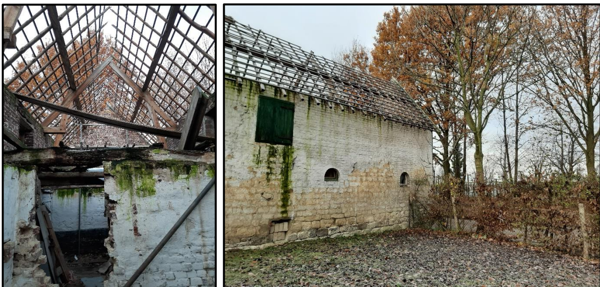
Figuur 1.2 situatie gebouw in het plangebied.
