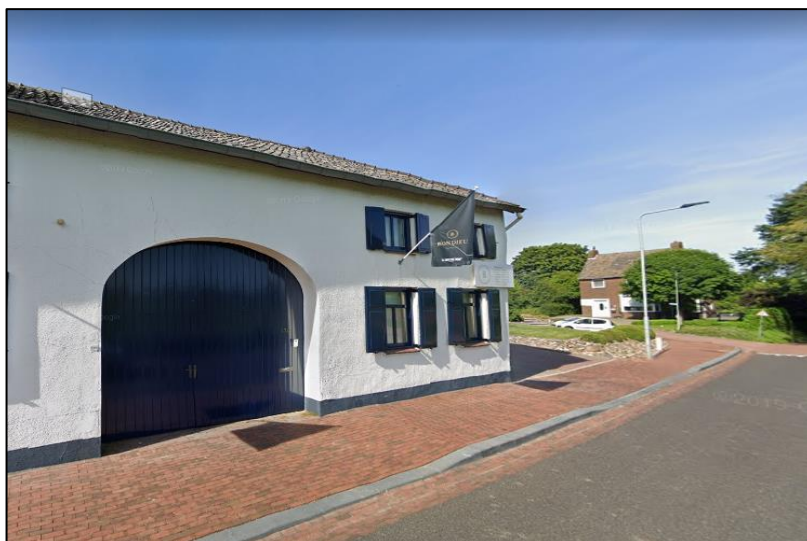
Foto's bestaande situatie
