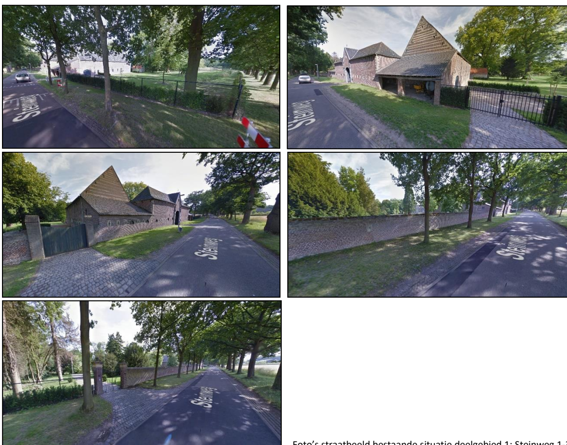
Foto's straatbeeld bestaande situatie deelgebied 1: Steinweg 1-3
