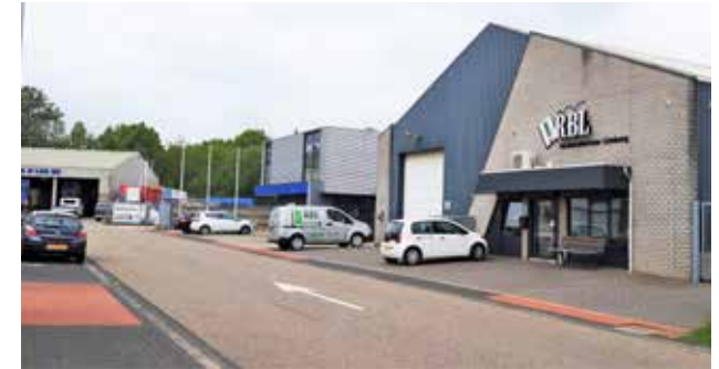
Afbeelding 4: uitritten in rode steen, parkeerplaatsen in zwarte steen
