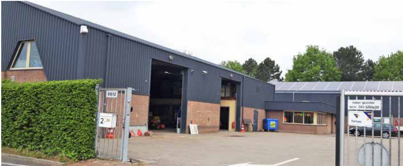
Afbeelding 6: Gemetselde plint, stalen gevelbeplating
