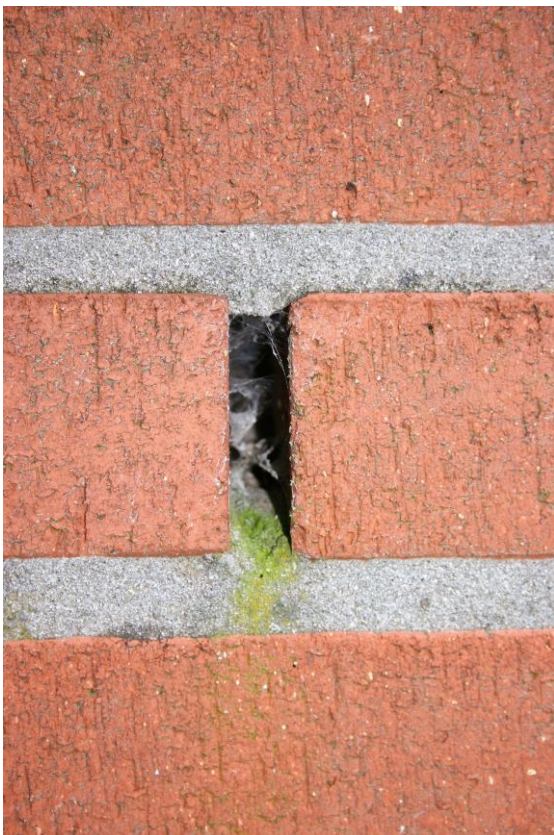
Figuur 12. Open stootvoeg gevuld met spinnenrag.
