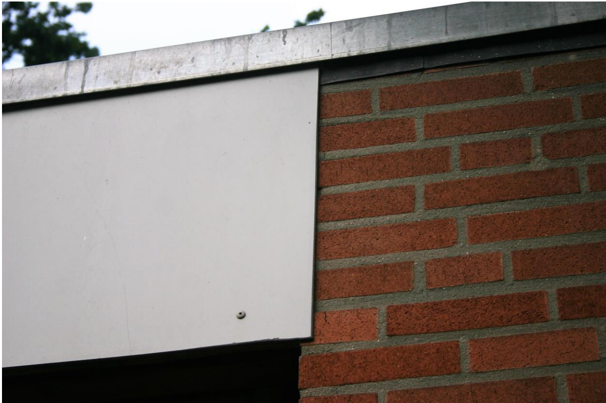
Figuur 13. De trespa-platen onder het dak sluiten overal nauw aan op de gevel.
