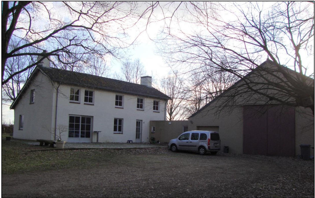
De oost- en achtergevel van de woning en de oostgevel van de schuur
