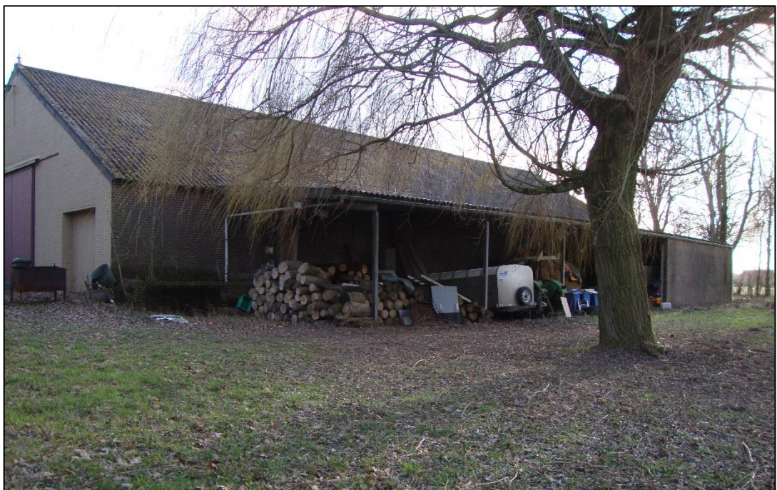
De overkapping ten noorden van de schuur
