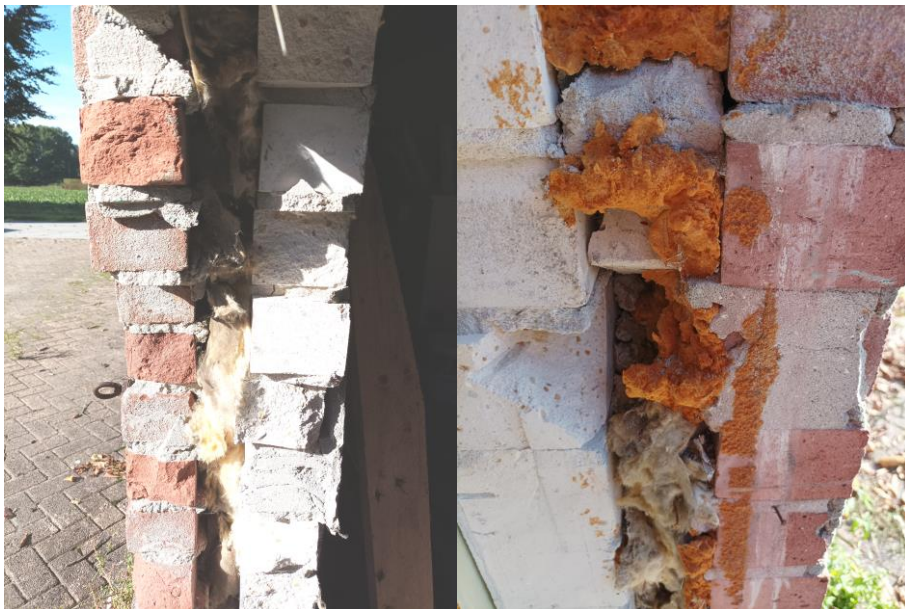
Figuur 4.2.1 De spouwmuren volledig opgevuld met isolatiemateriaal.
