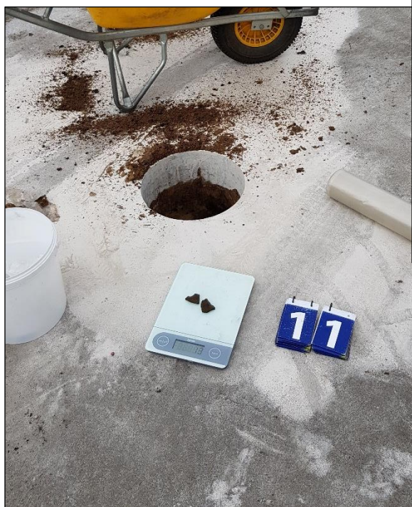
Foto's inspectiegaten en sleuven
