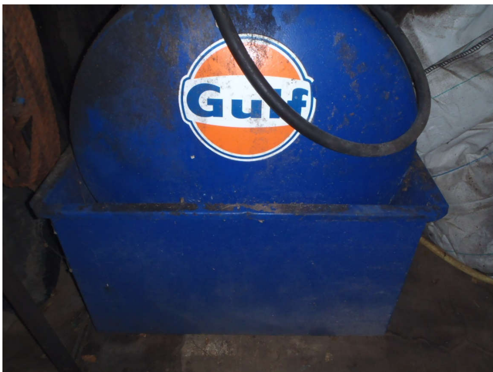
Foto bovengrondse tank in lekbak
