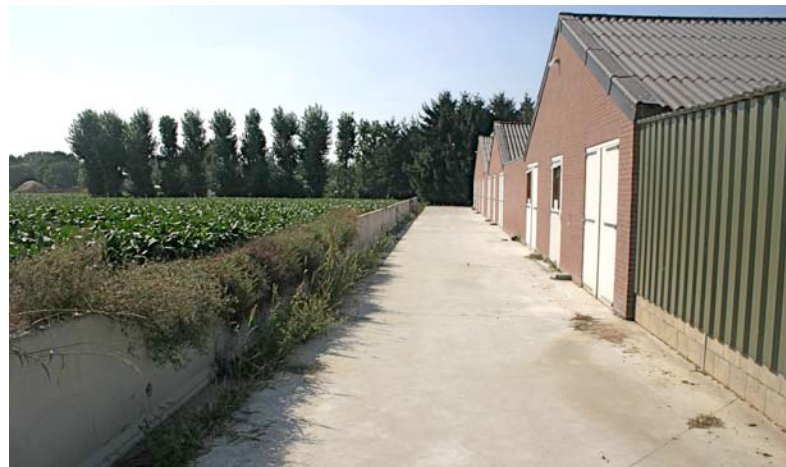
verharding en grondkering zuidoostkant
