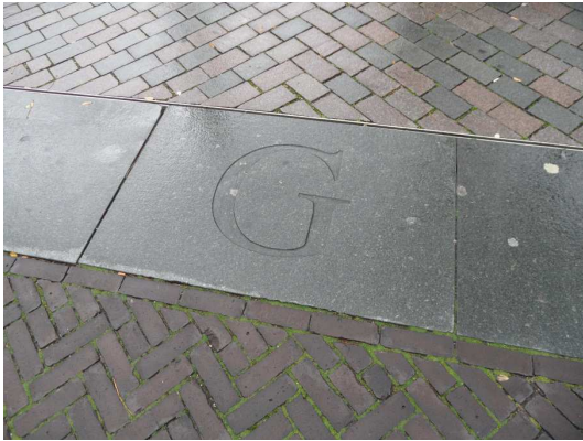
Nieuwe bestrating (COS project)
