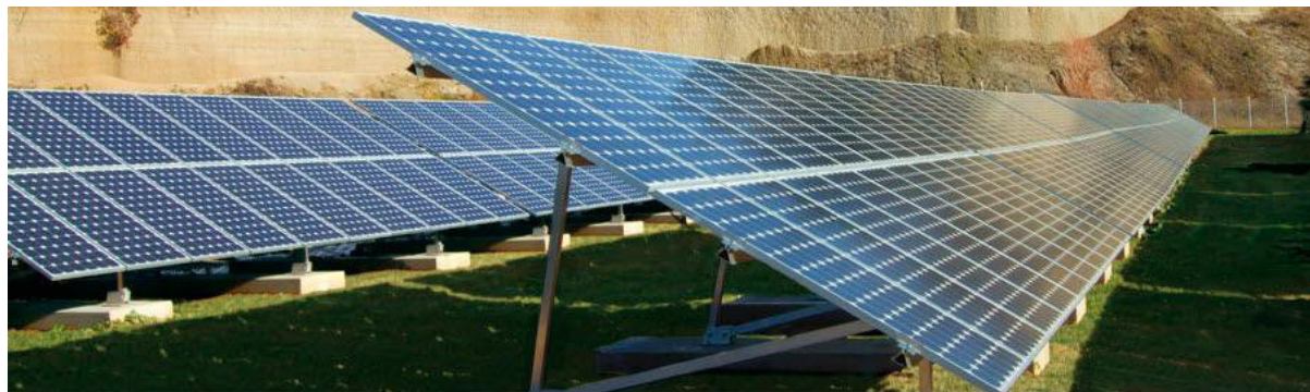
Afbeelding 22: Voorbeeld onderconstructie met betonvoeten
