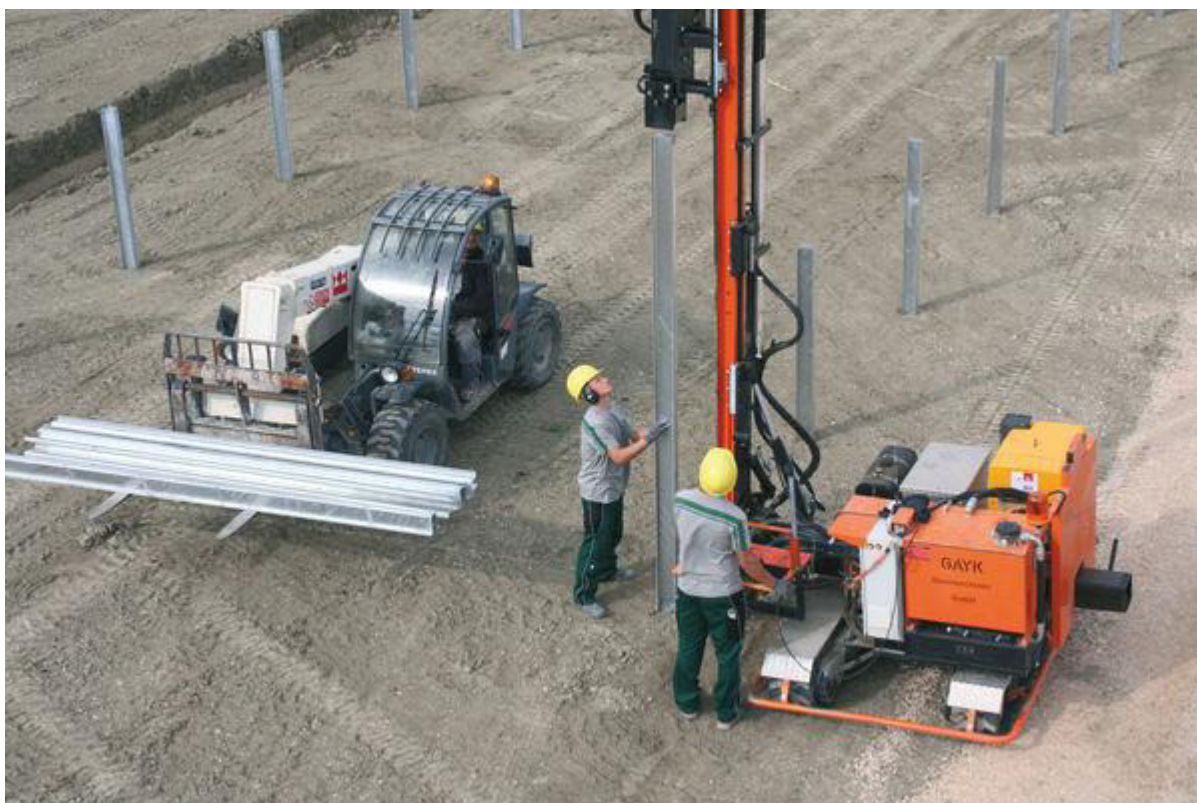
Afbeelding 12: Heiwerkzaamheden tijdens bouwfase zonnepark
