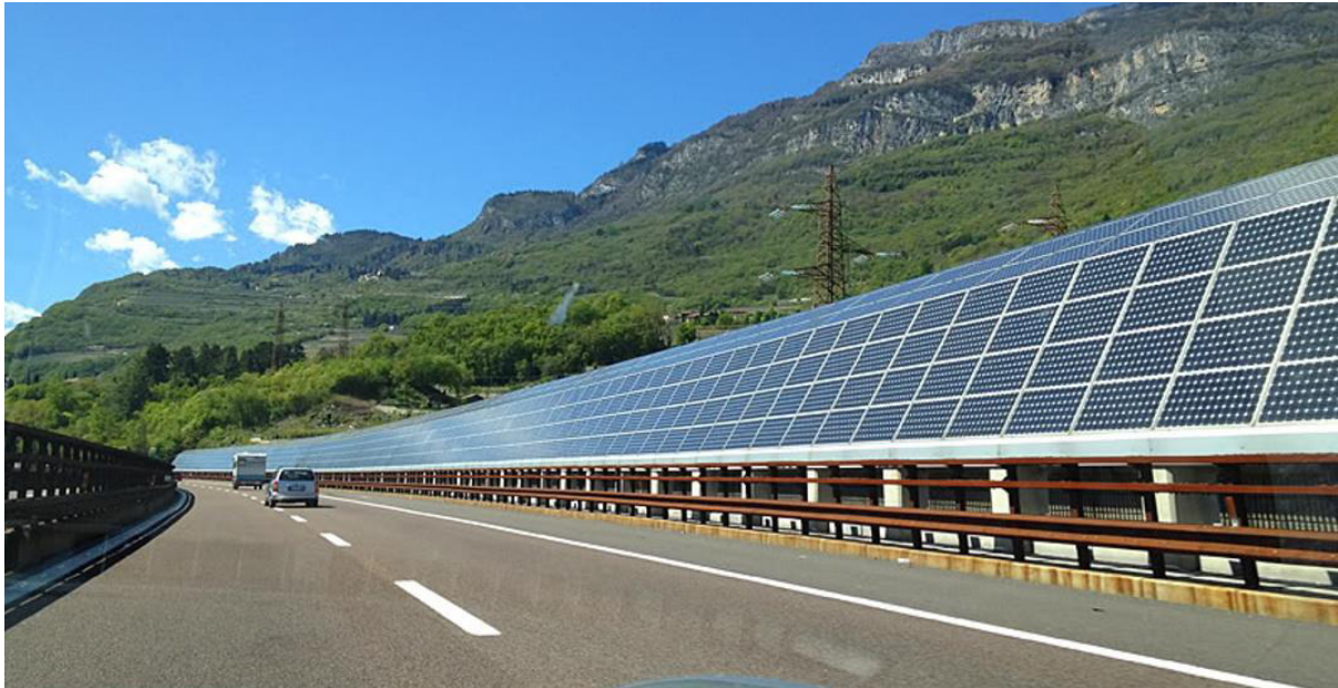
Afbeelding 24: Zonne installatie langs de “Brennerautobahn” in Italië
