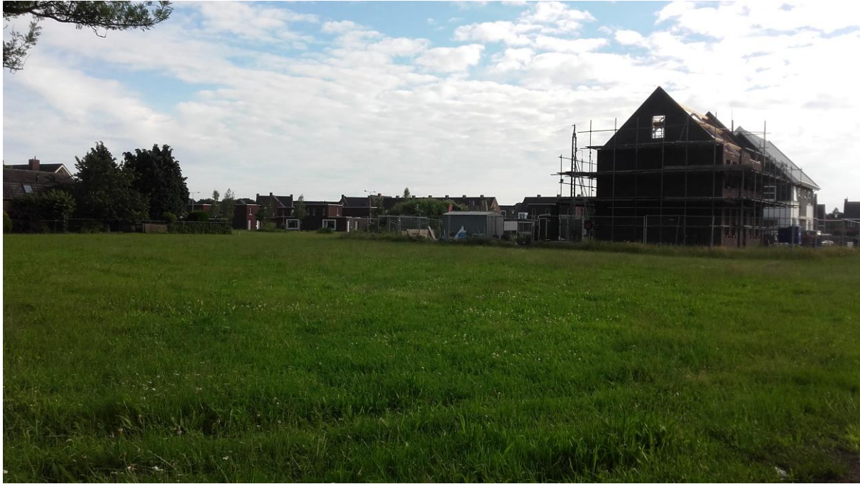
Foto's bestaande situatie
