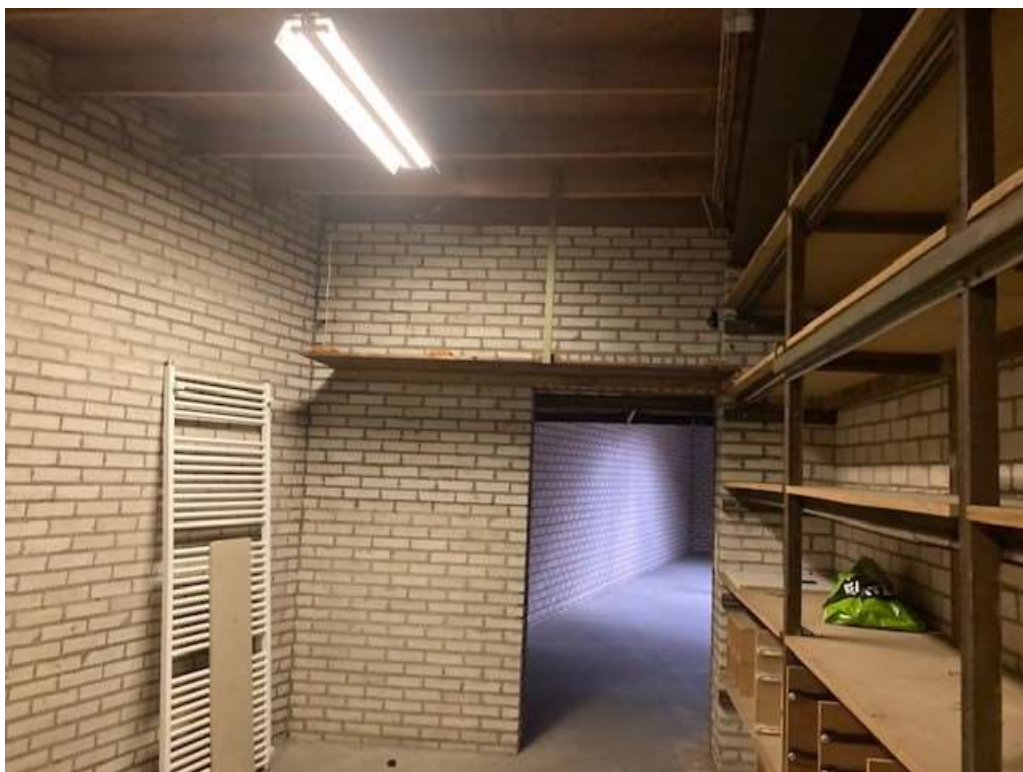
• Afbeelding 12: Binnenzijde bedrijfsgebouw
