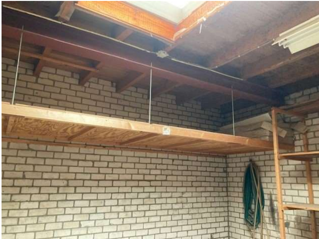
• Afbeelding 14: Binnenzijde bedrijfsgebouw
