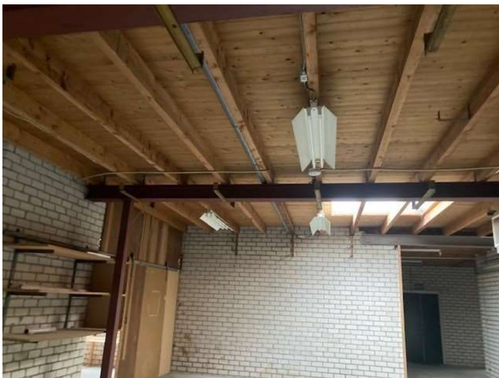
• Afbeelding 13: Binnenzijde bedrijfsgebouw
