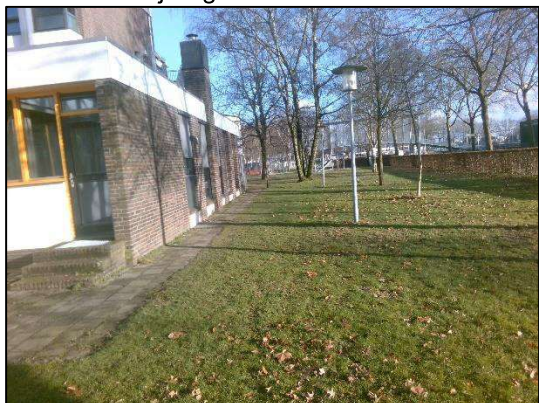
Foto 1: zuidzijde gebouw D
