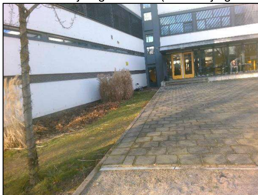
Foto 2: zuidzijde gebouw C (noordelijk gericht)
