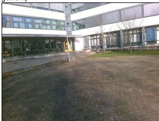
Foto 6: zuidzijde gebouw C (noordoostelijk gericht)
