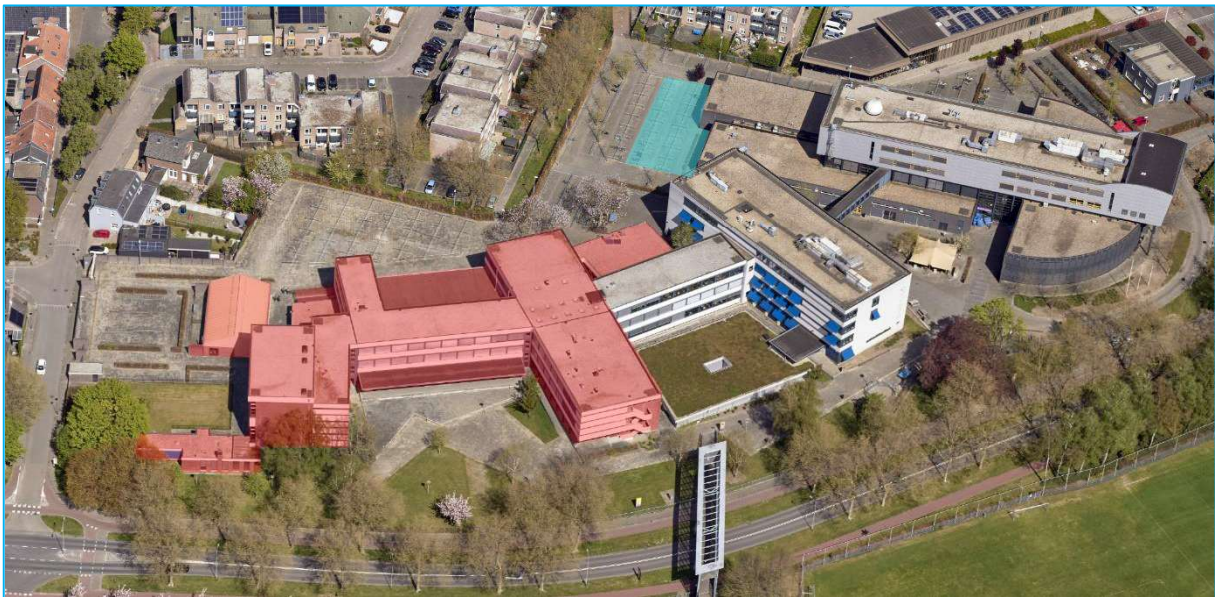
Afbeelding: Te slopen bebouwing Zuidsingel, Venray
