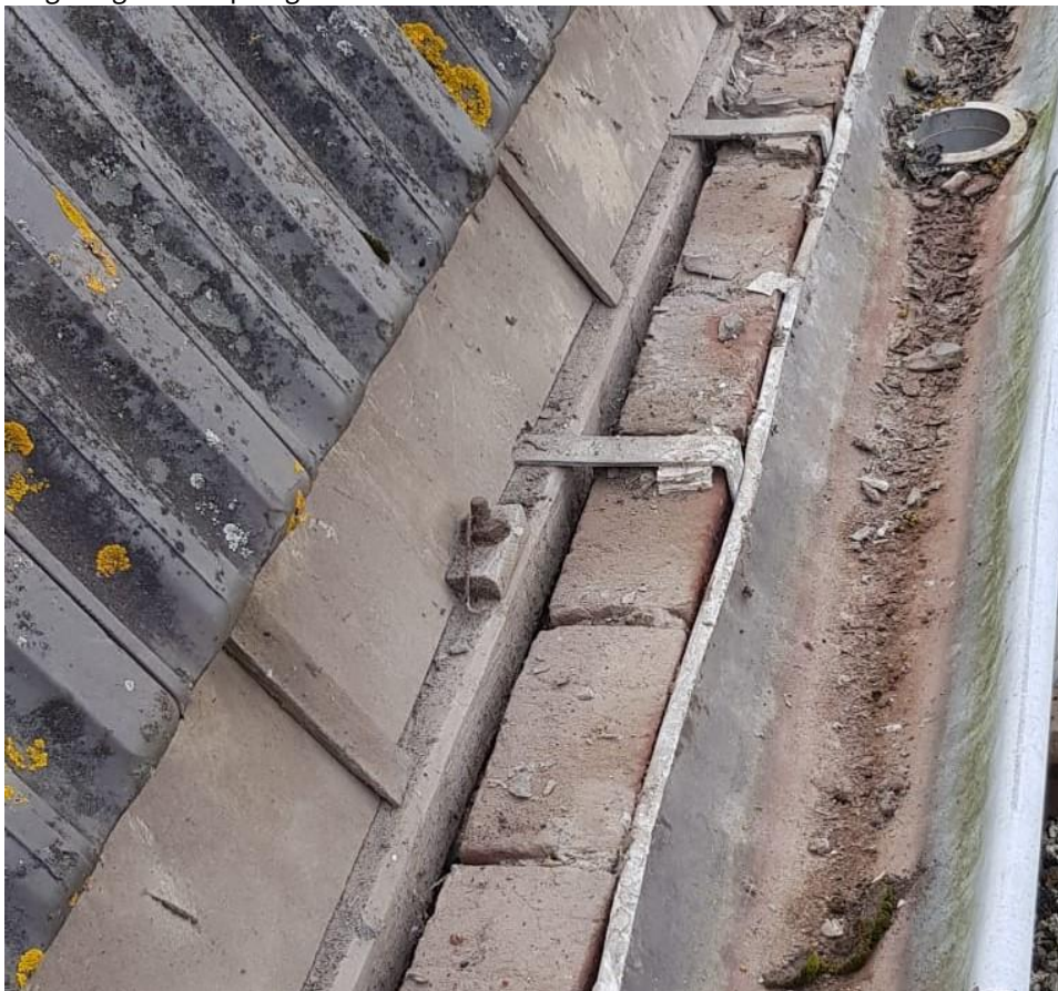
Controle onderste rij pannendak
