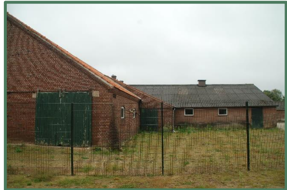
Woonboerderij achterzijde met aangebouwde stal
