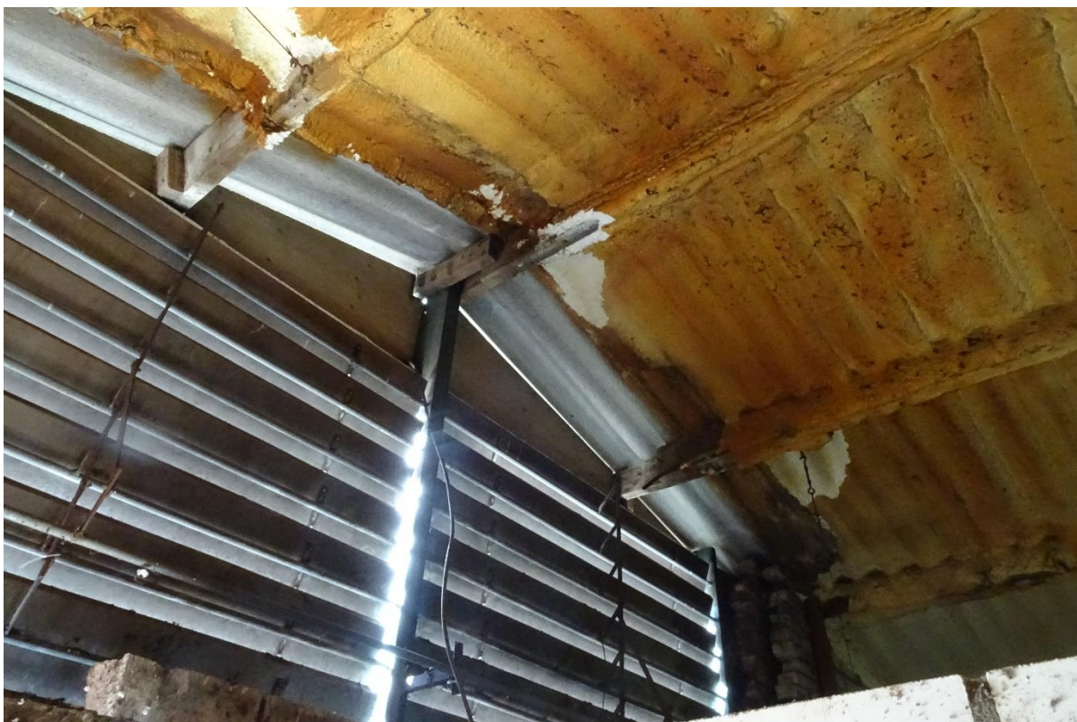
Afbeelding 15: Daken van de stallen na geïsoleerd met purschuim. De ventilatieroosters zijn aan de buitenzijde afgedicht met gaas, waardoor hier niets naar binnen kan komen. Bron: R.J.L. Bijvelds 29-03-2021
