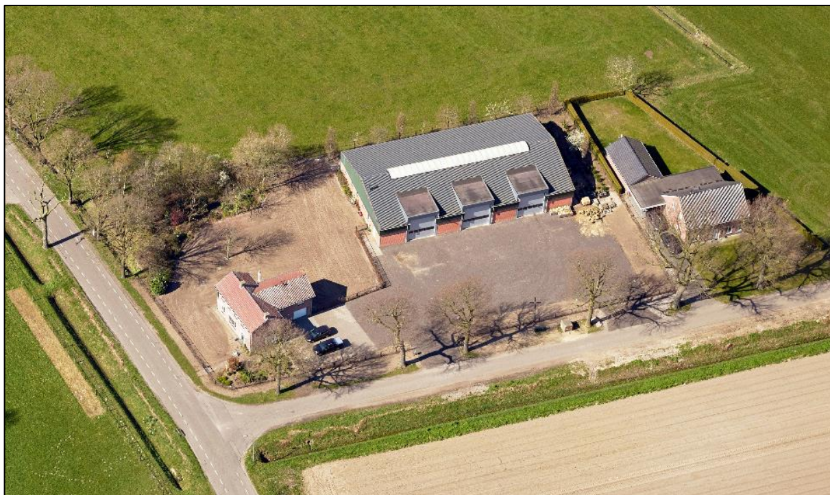
Afbeelding 13. Huidige situatie Houbenweg 1a (loods 2 is inmiddels gesloopt en dus niet meer zichtbaar)
