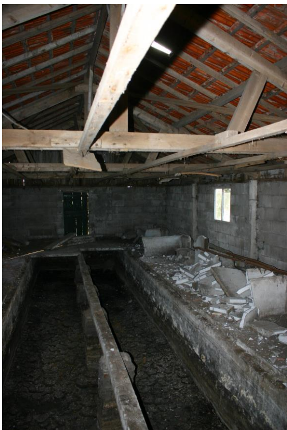
Figuur 4.2.1. Het dak en de muren van stal 1 (zie figuur 4.1; zie grote foto voorzijde) zijn volledig enkelwandig.
