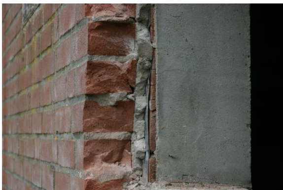
Figuur 4.2.3. Hier is goed te zien dat varkensstal B geen spouw bevat.
