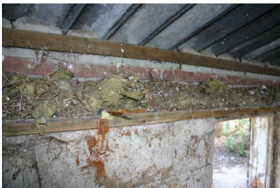
Figuur 4.2.4. De spouwen in varkensstal C zijn volledig gevuld met steenwol.
