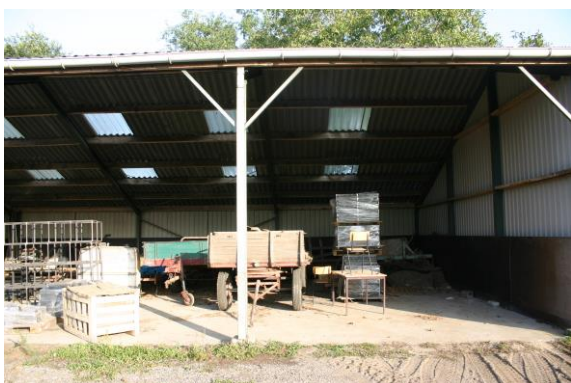
Figuur 4.2.6. De wanden en het dak van de open opbergschuur zijn enkelwandig.
