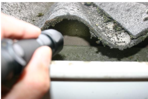
Figuur 4.2.2. De ruimte onder elke 'golf' in het dak van varkensstal A is afgedicht.
