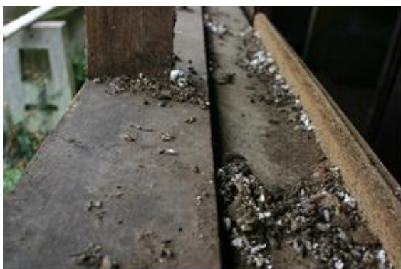
Figuur 4.2.2. De muurplaat dicht de spouw volledig af.
