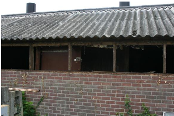
Figuur 4.2.1. De muurplaat dient tevens als raamkozijn.
