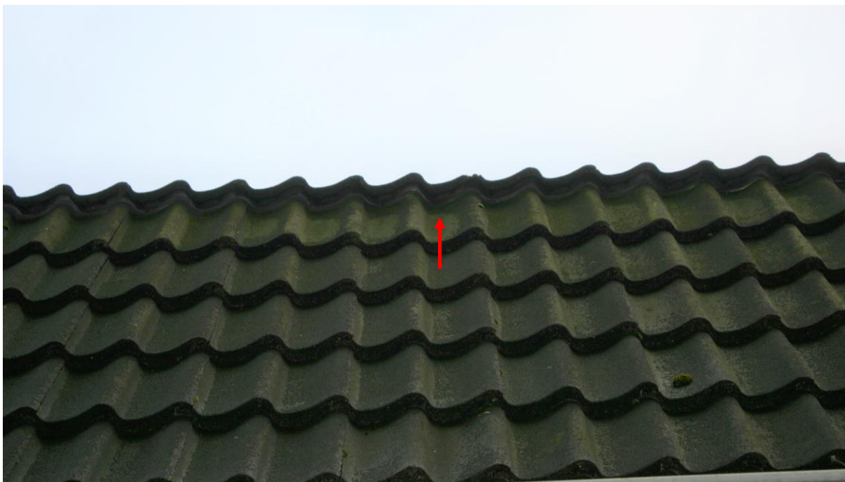
Figuur 4.2.3. In de knik tussen de twee dakvlakken is een ruimte onder de dakpannen, over de gehele lengte van het dak.
