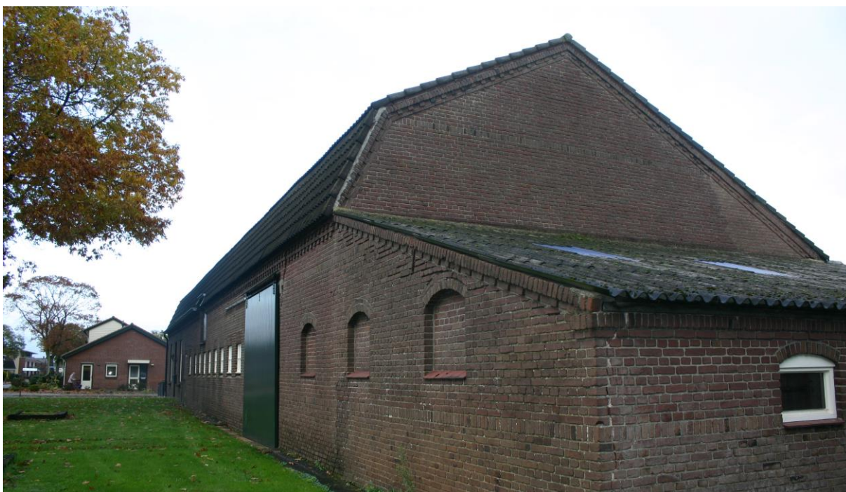
Figuur 4.2.2. De zuidgevel van de boerderij heeft overstekende gevelpannen, waarvan de meeste niet zijn afgestreeken met specie.
