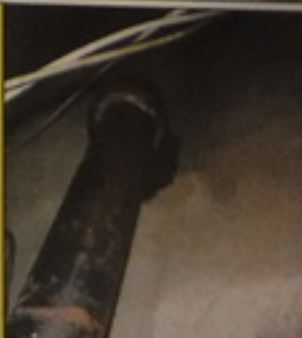
Kruipruimte: Koord in riolering (M17V)
