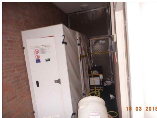
F2: 3-trapssluis met toebehoren
