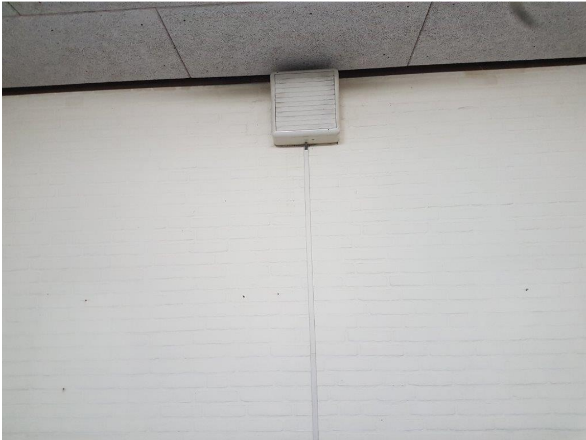
Ventilatie roosters aan de binnenzijde ter hoogte van de stootvoegen
