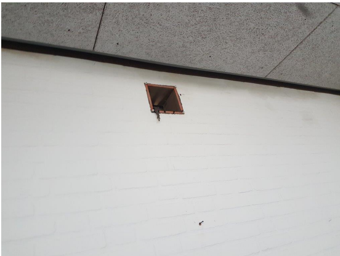
Afgesloten bak in de muur die de stootvoeg met de binnenzijde van het gebouw verbindt.
