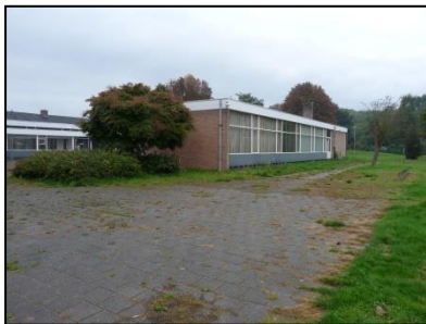
Figuur 3. Aanzicht in zuidwestelijke richting.
