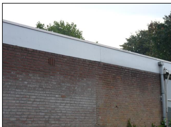
Figuur 12. Open stootvoegen in twee verschillende muur delen van het object.
