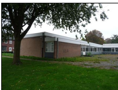
Figuur 6. Aanzicht in zuidwestelijke richting.
