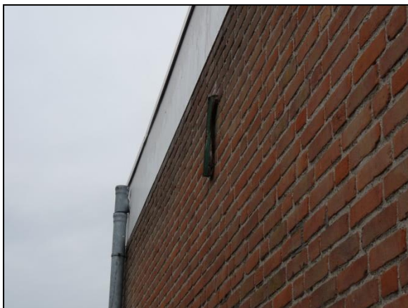
Figuur 9. Detailopname van de dakrand.
