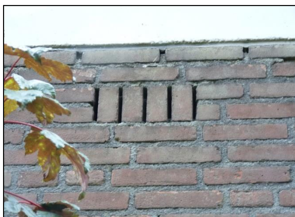
Figuur 11. Open stootvoegen in het object
