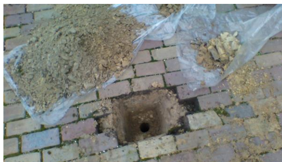
Foto 12. Asbestinspectiegat A20
