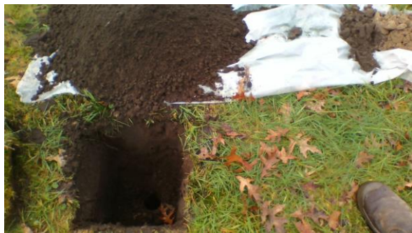
Foto 9. Asbestinspectiegat A12
