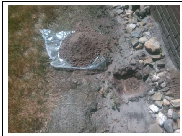
Foto 2. Asbestinspectiegat materiaal B02
