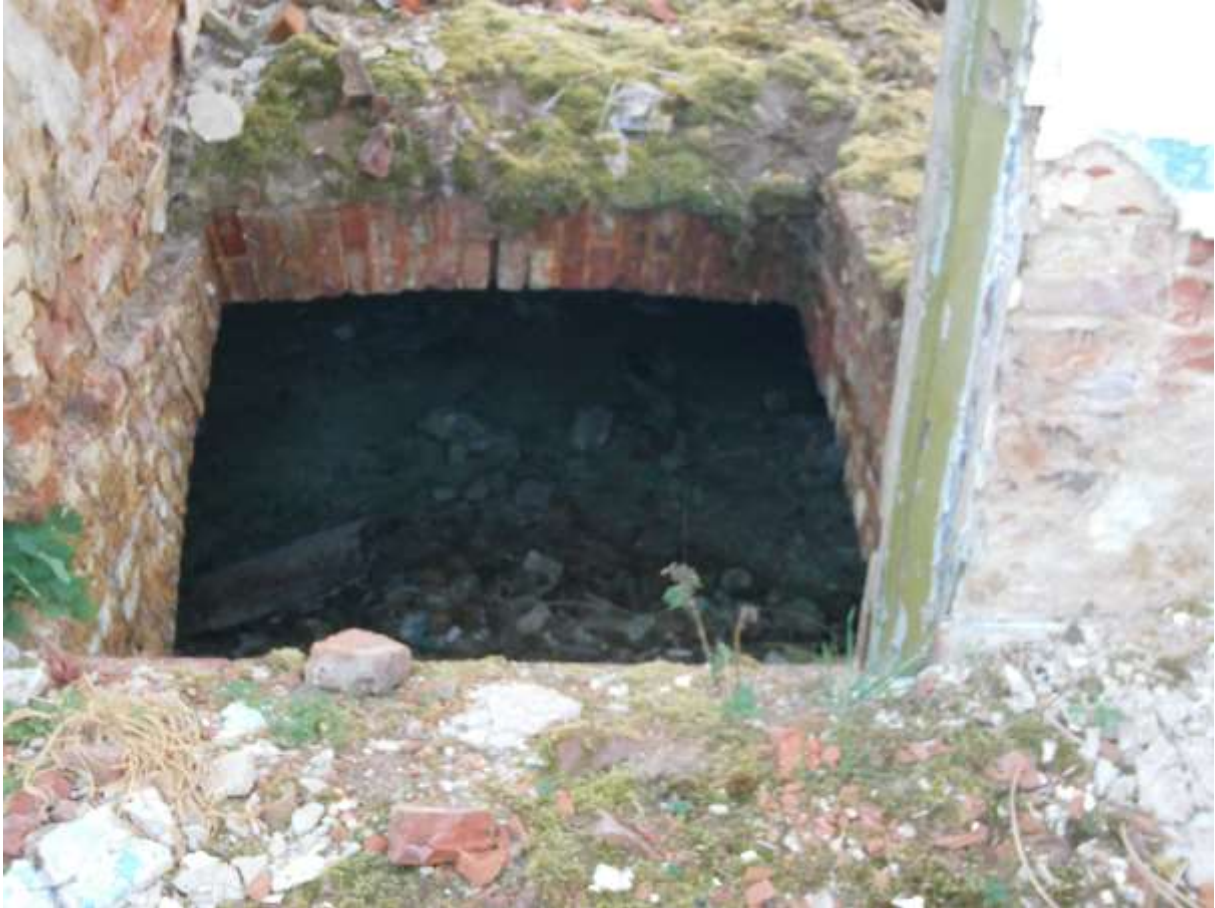
Figuur 21: Foto van een toegang tot één van de kelders onder de bestaande bebouwing
