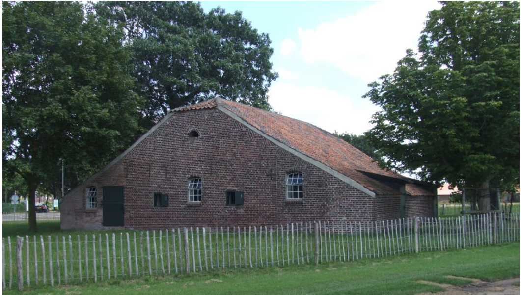
Aanzicht zijgevel vanuit zuidwestelijke richting
