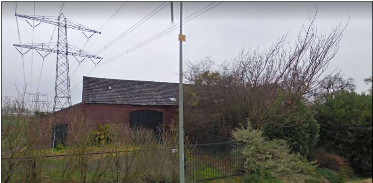
Figuur 3: Voorzijde bestaande woning Tunnelweg 7 Castenray
