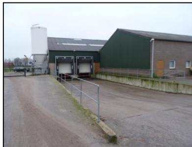
Figuur 4. De aanbouwlocatie.
