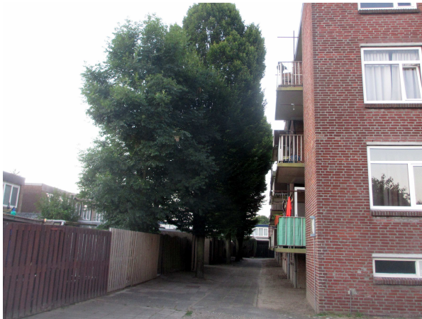
Fig. 5 Achterzijde van het meest oostelijke appartement (appartement 1)
