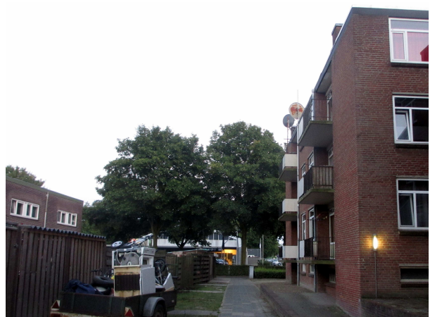
Fig. 6 Middendeel van het plangebied, foto genomen vanaf achterzijde appartement 2 richting de Zuidsingel.
