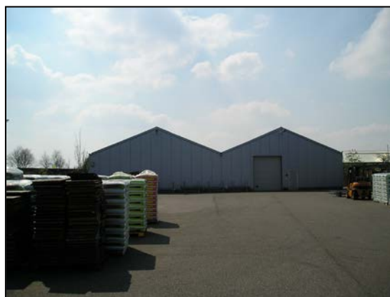
Figuur 2.5: opslagloodsen in het oostelijk deel van het plangebied
