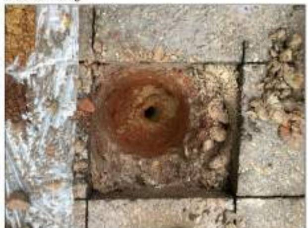
Foto 4 Inspectiegat 12 (zie volledige baksteenlaag)
