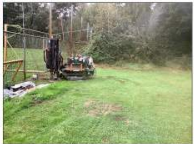
Foto 8 Plaatsing Peilbuis 02 (nabij boring 25)
