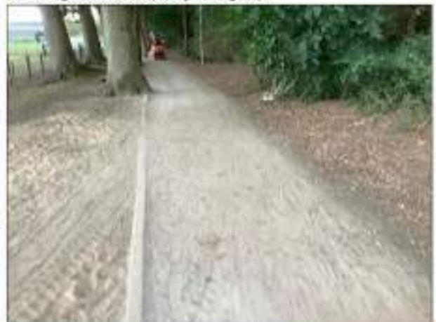
Foto 10 Gravelweg alwaar boring 06 en 07 staan
