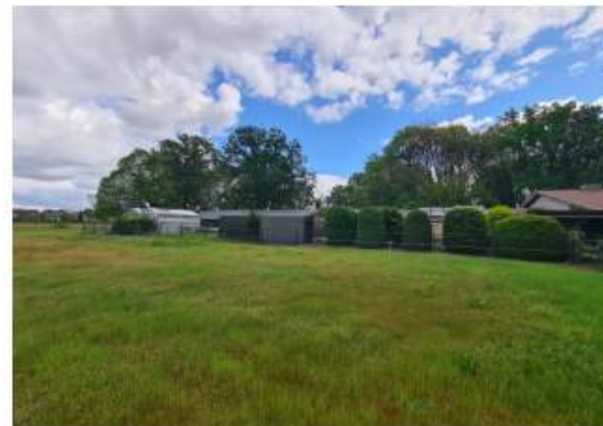
Figuur 11: Woning en schuur aan de Schansheideweg 22
