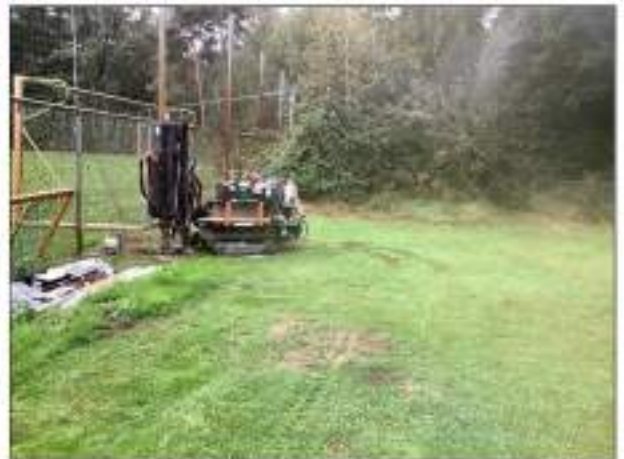
Foto 8 Plaatsing Peilbuis 02 (nabij boring 25)
