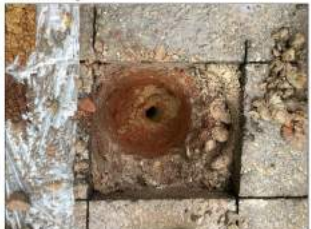
Foto 4 Inspectiegat 12 (zie volledige baksteenlaag)
