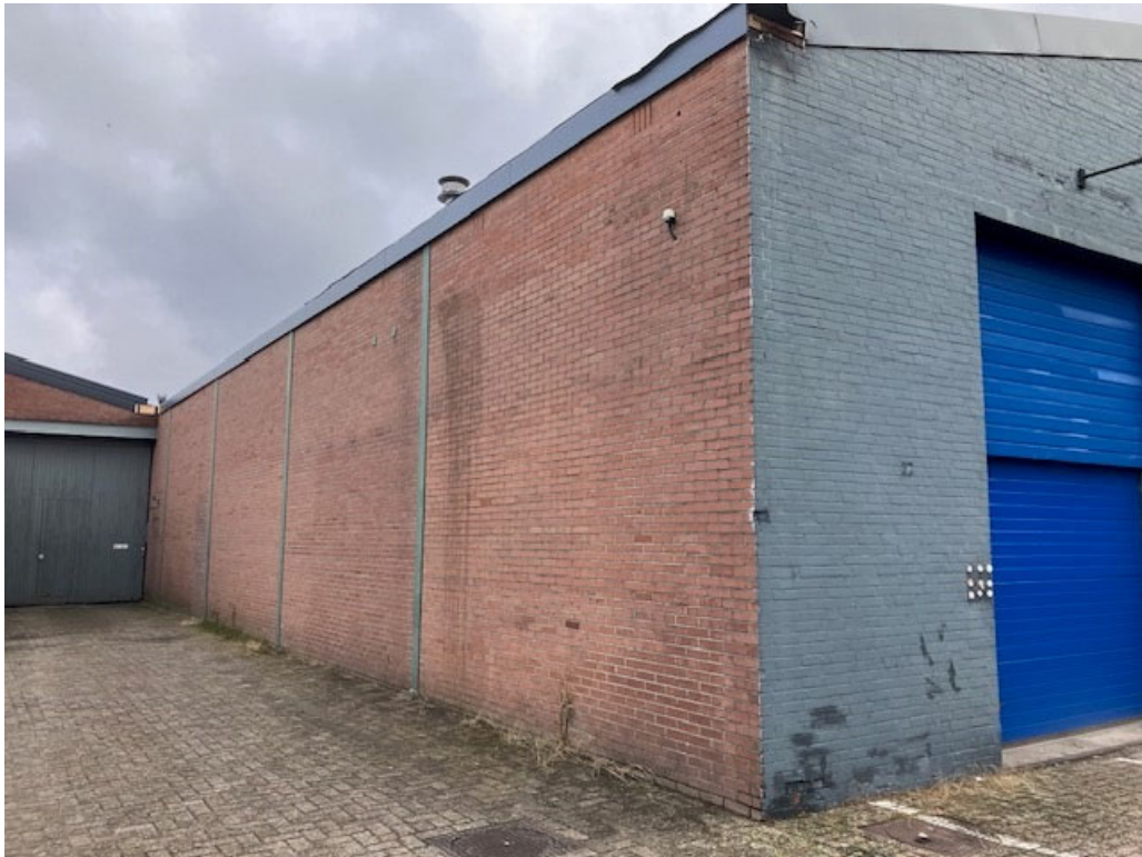
• Afbeelding 15: linker zijgevel hal, recentelijk voorzien van een nieuw dak
