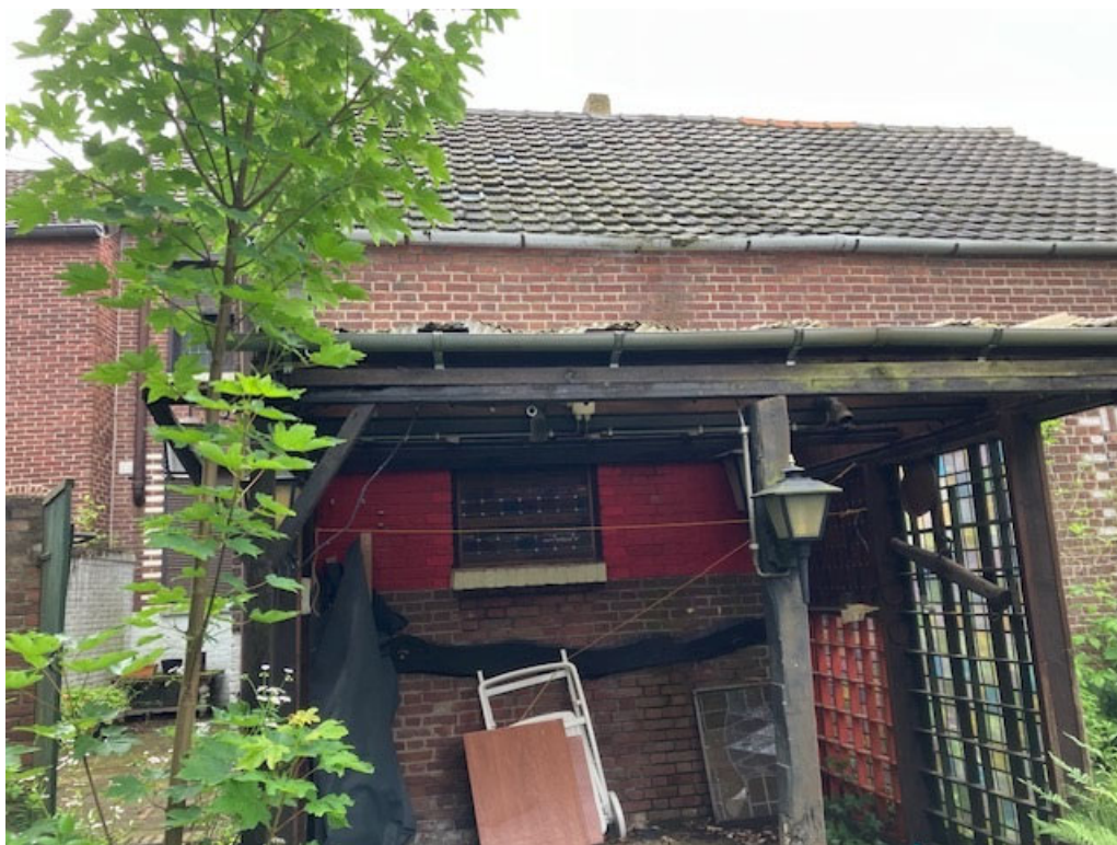
• Afbeelding 9: Overkapping aan achtergevel woning, blijft behouden
