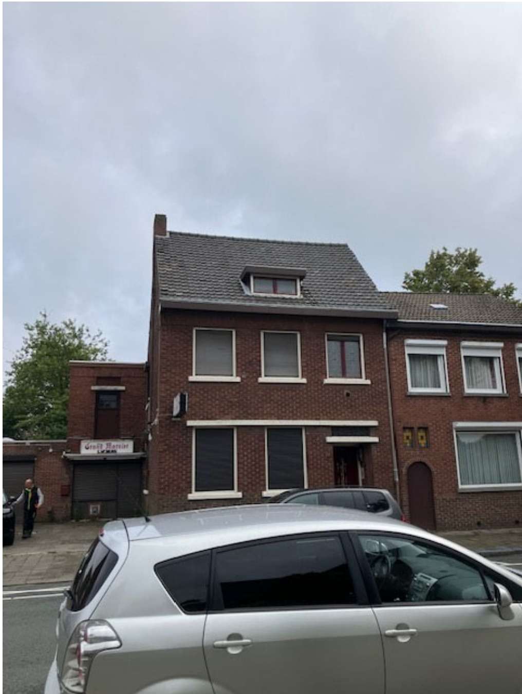
• Afbeelding 21: Voorgevel woning met links op foto de te slopen garage aan de aanbouw
