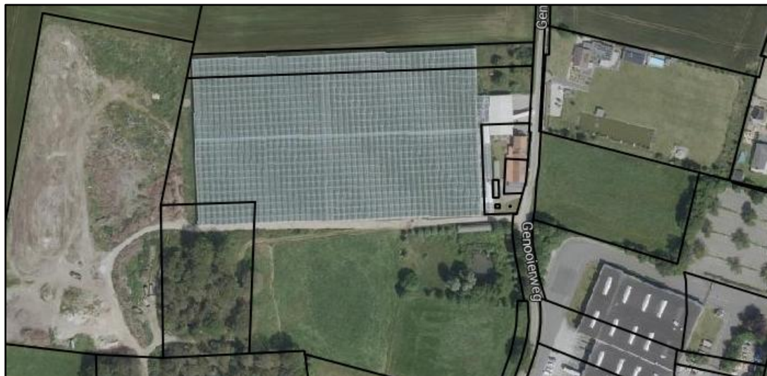
Figuur 1 Luchtfoto projectlocatie Genooierweg 22 te Velden
