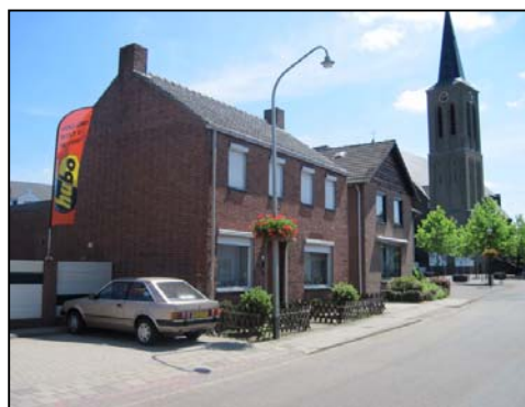
Afbeelding 8. Enkele woningen aan de Kloosterstraat
