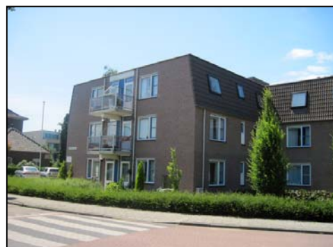
Afbeelding 6. Appartementencomplex aan Kloosterstraat
