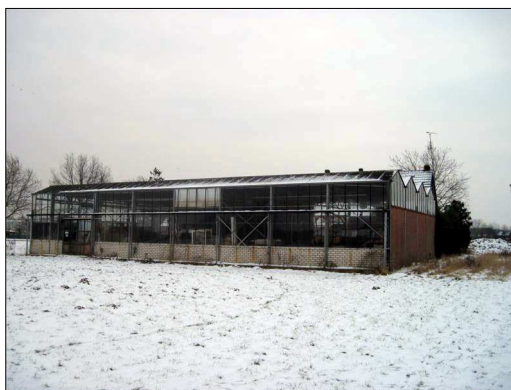
Afbeelding 12. Zicht op de loods achter de woning aan de Elshoutweg 2, gezien vanaf de achterzijde.
