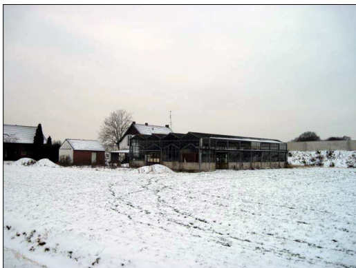
Afbeelding 7. Zicht op de achterzijde van de woning inclusief bijgebouwen aan de Elshoutweg 2
