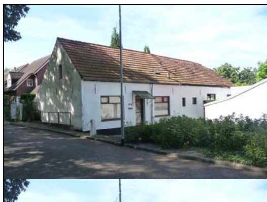
Afbeelding 3: Te slopen woning
