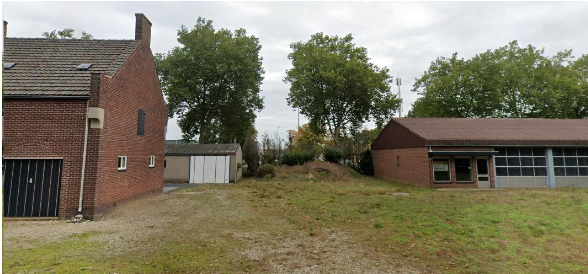
Afbeelding bestaande situatie (Bron: Google Streetview)
