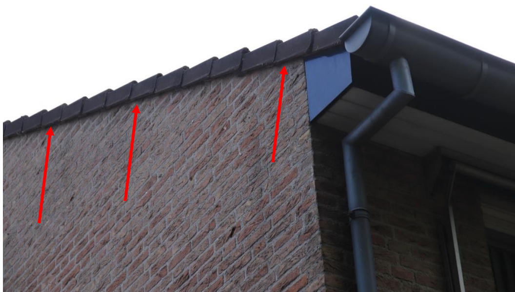
Foto 3: De kopgevelpannen bieden geschikte invliegopeningen voor vleermuizen, echter blijven deze intact
