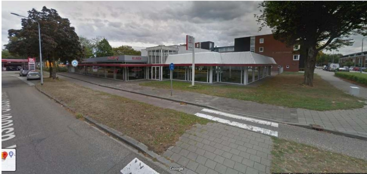
bestaande situatie (bron: Google Maps)
