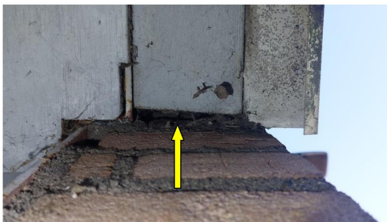
Figuur 4.4.1. Een spleet onder een overstek waardoor vleermuizen de achterliggende ruimte kunnen bereiken.
