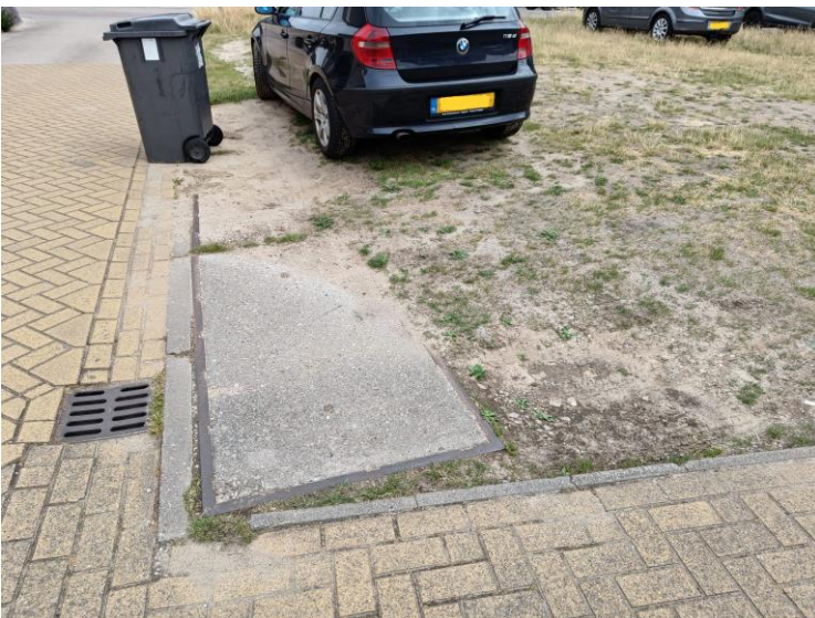
Figuur 4: Stelconplaten binnen onderzoekslocatie
