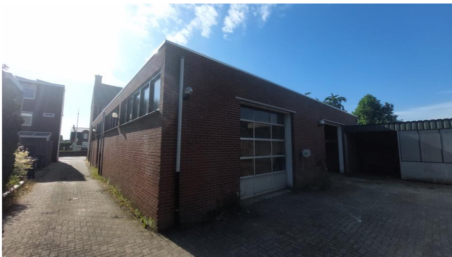
Figuur 4.2.1. De garage (1 in figuur 4.1) bevat een plat bitumen dak en gemetselde spouwmuren zonder open stootvoegen of spleten.
