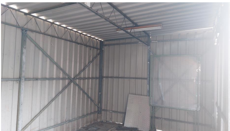
Figuur 4.2.2. Het schuurtje (2 in figuur 4.1) bestaat geheel uit enkelwandige damwandplaten.
