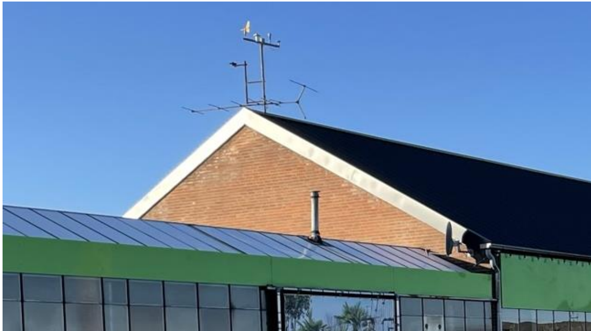
Figuur 2: De oostgevel van de winkelruimte aangrenzend aan de onderzoekslocatie.
