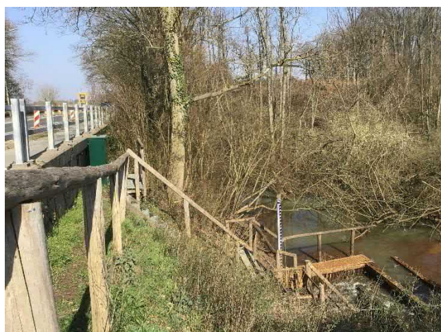
Foto 3: Taludtrap Oostzijde (deellocatie 3)
